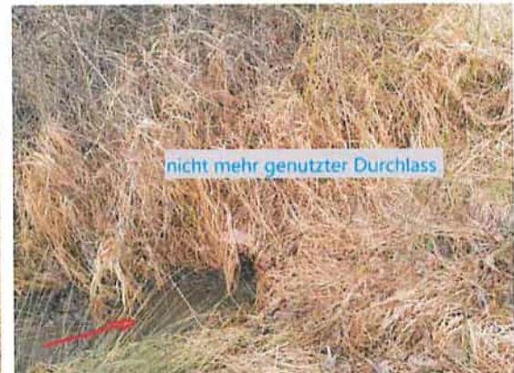
Foto 6: Einlaufbereich eines nicht mehr genutzten Durchlasses
