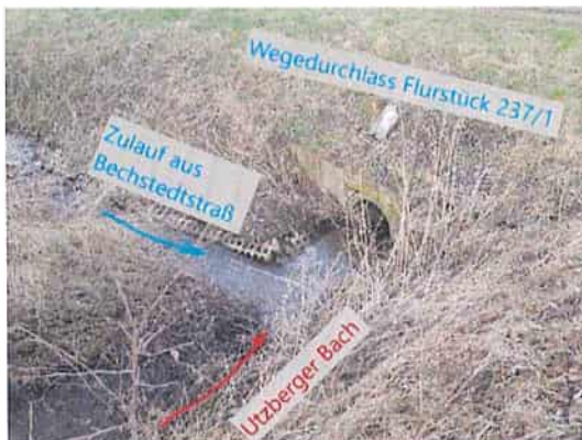
Foto 33: Zulauf aus Bechstedtstraße
