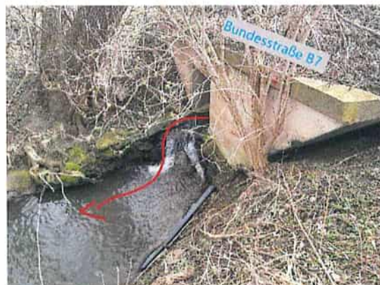
Foto 64: Gewässerprofil unterhalb des Durchlasses B 7
