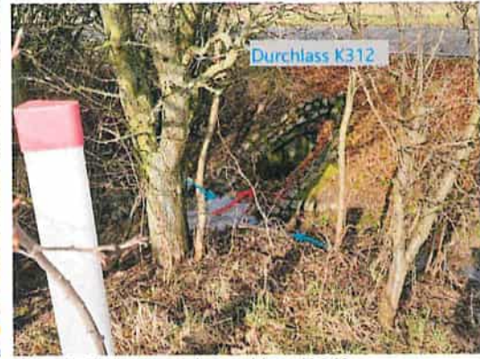
Foto 11: Einlaufbereich Durchlass K 312
