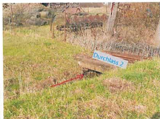
Foto 16: Einlaufbereich Durchlass 2
